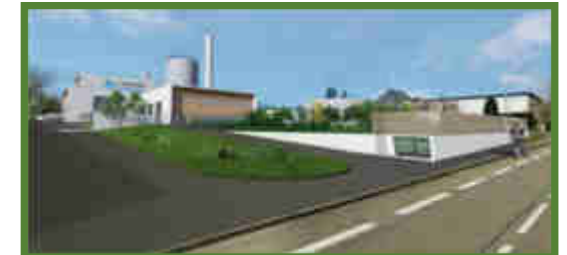
Chaufferie biomasse et gaz route de Beaugé
